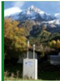
Chamonix - Les Bossons Bordure Chaussée RN 205
