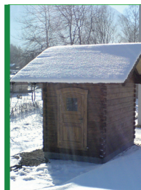
Chamonix - Les Bossons Bordure Chaussée RN 205
